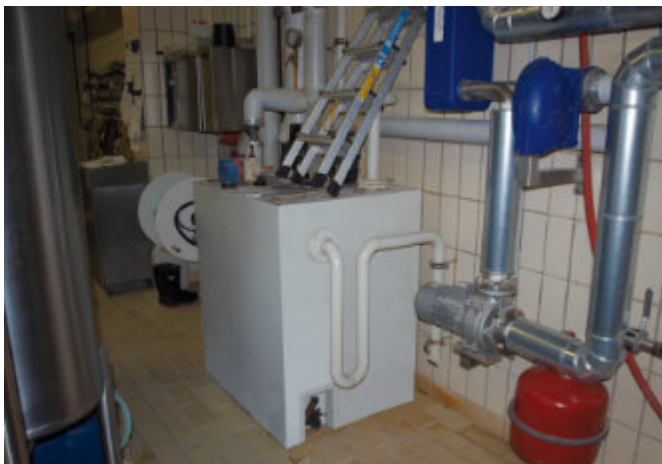
Kondensatrückführungsanlage für größere Mengen
