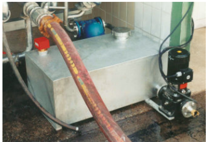
Pumpsystem mit Kondensatauffangbehälter
